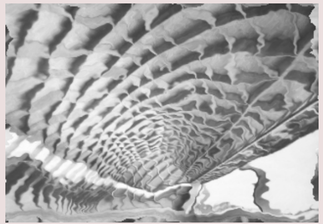
Pier Luigi Nervi, Hangar de l'aérodrome d'Orbetello , en Toscane (Italie), 1939-42, béton armé. Cette architecture est détruite de nos jours.
