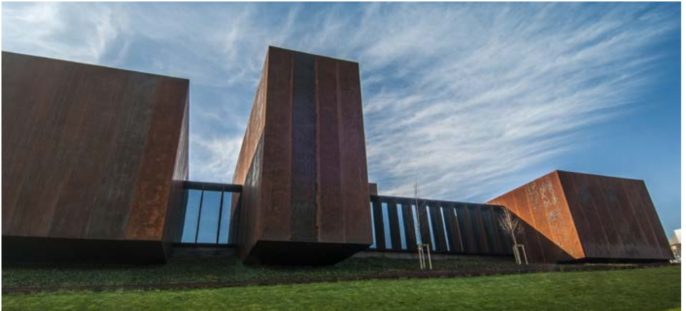
RCR Architectes - musée Soulages - Photo : A. MéraVilles
