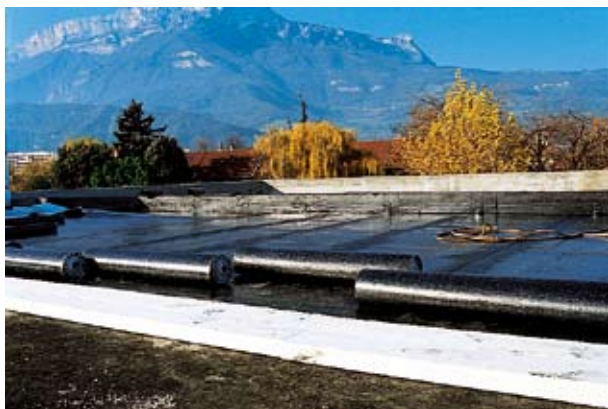
L'isolation d'une toiture-terrasse
