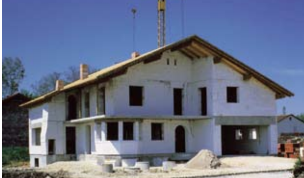
Construction en béton cellulaire
