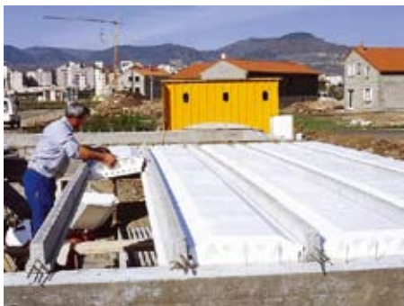
Entrevous PSE pour l'isolation des sols entre poutrelles.
