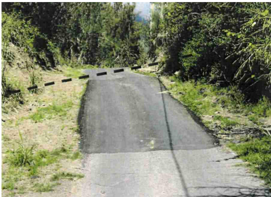
Figure 4: Déformation du chemin en béton reliant la RD48 et le Fond de Rond-Point, dans le glissement de Mare à Poule d'Eau. Le rejet vertical est métrique. Photo correspondant à la Figure 20 de Garnier et Lucas, 2008.
