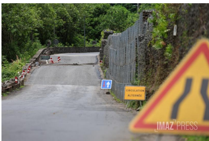
Figure 3 - la RD48 coupée en 2024 suite à une déformation de la chaussée (Photo photo Sly/www.imazpress.com)
